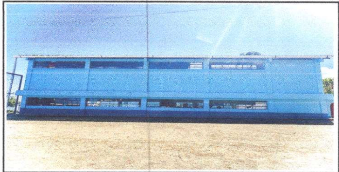
Foto 2: Sustitución de Canal y bajada de agua pluvial de metal por tubo PVC 3". Aulas Módulo 2
