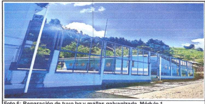
Foto 6: Reparación de tubo hg y mallas galvanizada. Módulo 1
