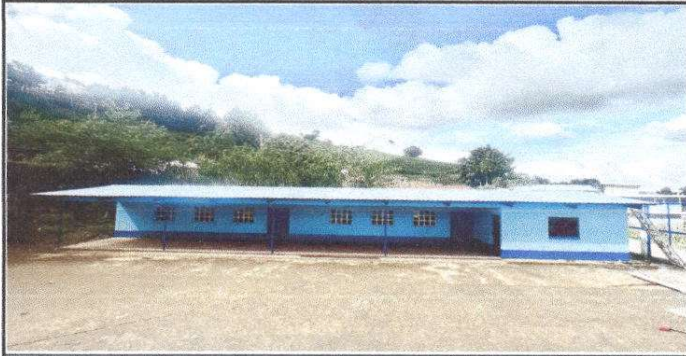
Foto 1: Sustitución de lámina, por lámina troquelada aluzinc calibre 26. Aulas Módulo 1
