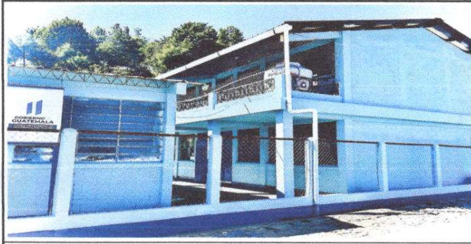
Foto 3: Sustitución de canal de pvc. Aulas Módulo 2
