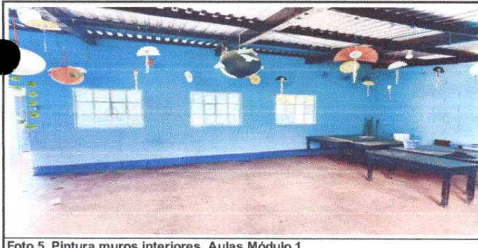
Foto 5: Pintura muros interiores Aulas Módulo 1
